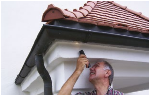
Abb. 20: Kontrolle des Quartiers im Dachkasten
